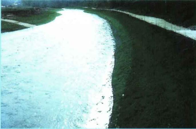
d) La protection a été conçue et basée sur l'utilisation de \*graminées à action immédiate. Les berges ont très vite été couvertes et le \*géotextile provisoire a été enlevé. Les plantations sont réalisées.
