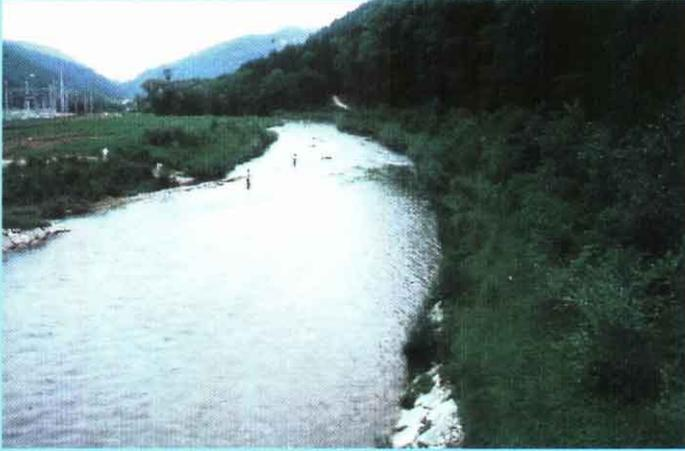
e) Les espèces ligneuses ont participé ultérieurement à la stabilisation générale. Avec une variabilité du tracé, des berges et des structures végétales, la rivière offre un aspect naturel et des fonctions biologiques réelles déjà quelques années après les travaux.
